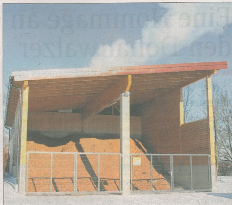
Am Schulgelände befindet sich auch das neue Heizwerk, das umweltfreundlich und kostengünstig die Schule beliefert. Foto: Franz Dangl
