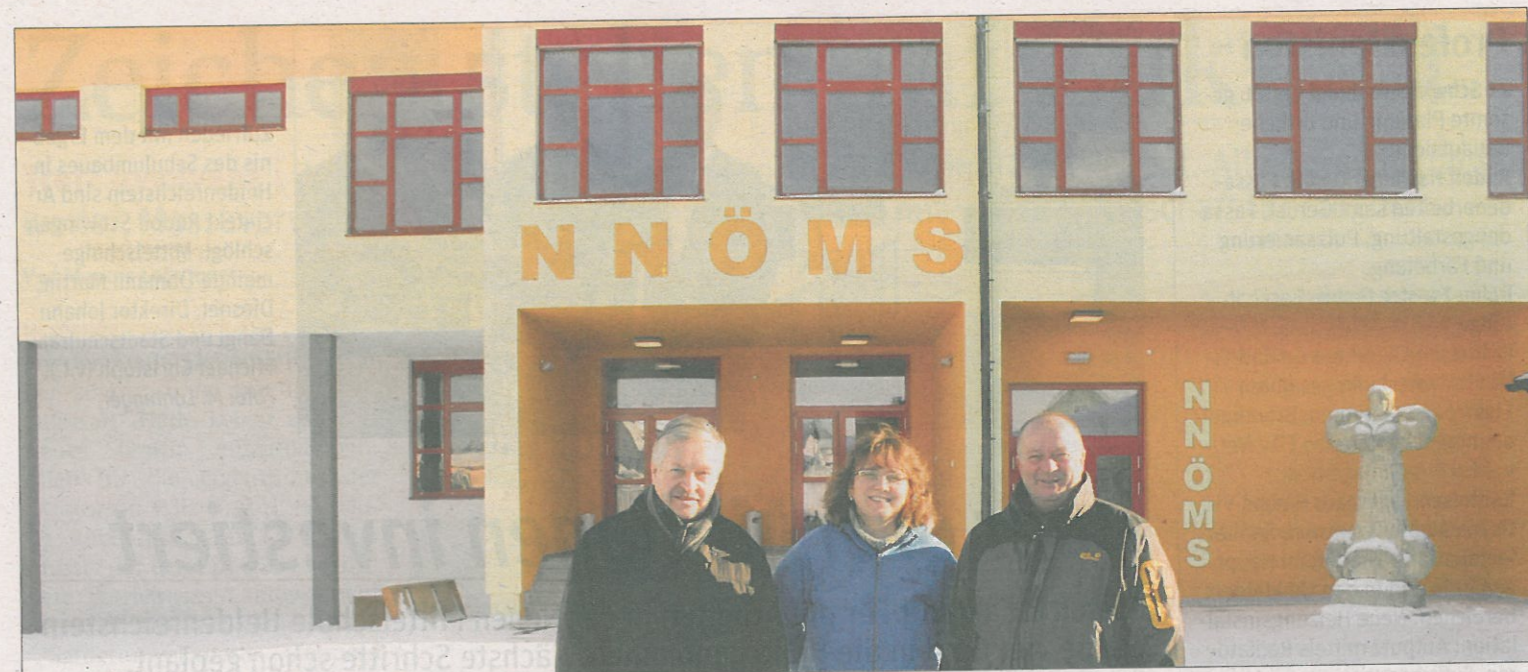
Freuen sich über den Umbau und die Sanierungsmaßnahmen in der Neuen Mittelschule: Bürgermeister Gerhard Kirchmaier, Elternverein-Obfrau Irene Hager und Direktor Johann Dangl (von links nach rechts). Foto: Franz Dangl
